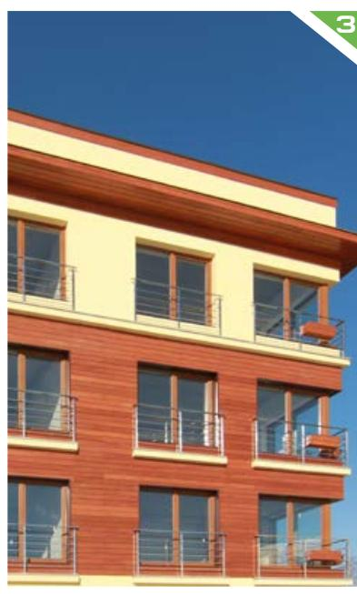
Фасады жилых зданий с помощью Art-Space частично облицованы компакт-пластиком HPL производителя Fundermax.
